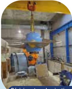
Révision et modernisation de turbine et vantellerie
