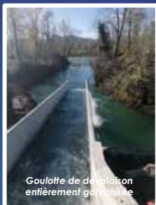
Mise en service de la passe à poissons de la centrale de Bizanos (dept 64)
